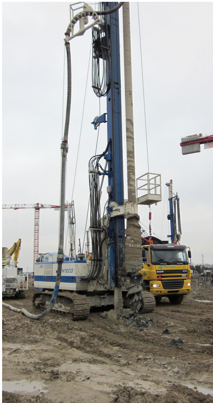
Momenti di lavorazione in cantiere.
