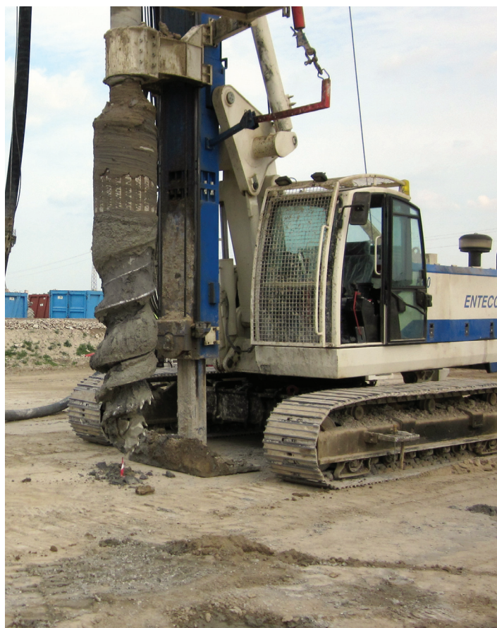
Utensile per palo Locafond SP di Diametro 620 mm.
