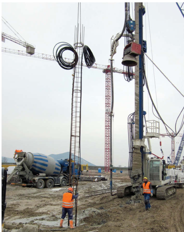
Infissione gabbie con sonde geotermiche.
